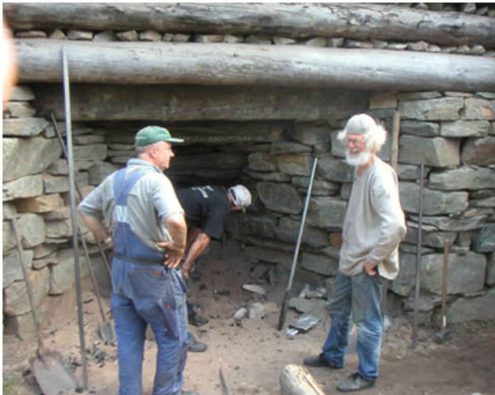
Bilden visar den rekonstruerade masugnen från ”nya Lapphyttan” utanför Norberg. Där har man under flera år förgäves försökt göra smältor på samma sätt som på 1300-talet. Trots hjälp av experter från SSAB, Fagersta
